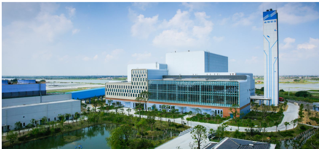
图一：嘉善垃圾焚烧发电厂
